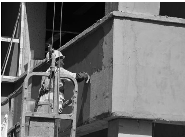
图2 建筑外墙抹面砂浆施工
