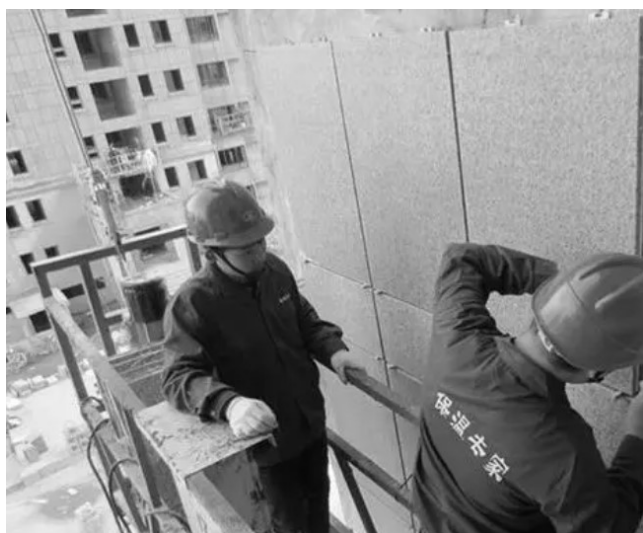
图1 外墙粘贴保温板施工
