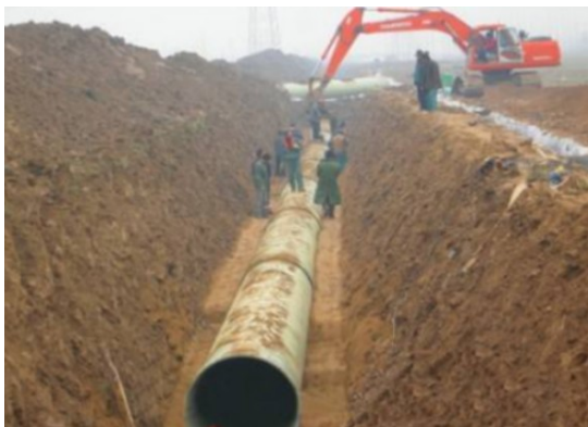
管道放坡开挖
