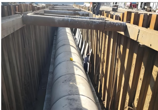
管道支护开挖
