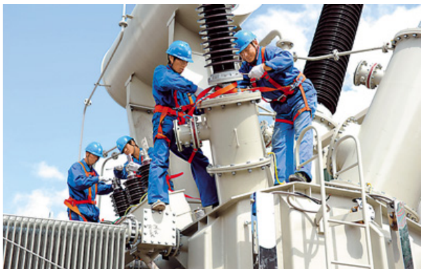
图一 电气工程安装和土建施工的配合
