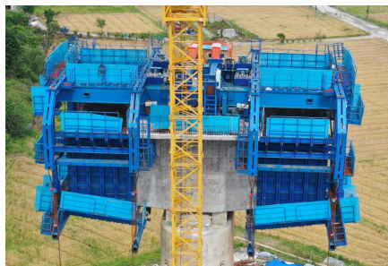
图1 造桥机构造示意图
