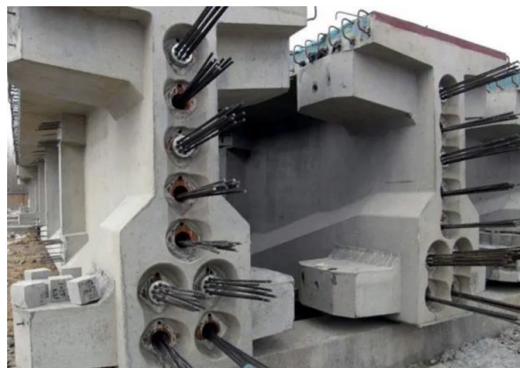
图3 预应力筋张拉
