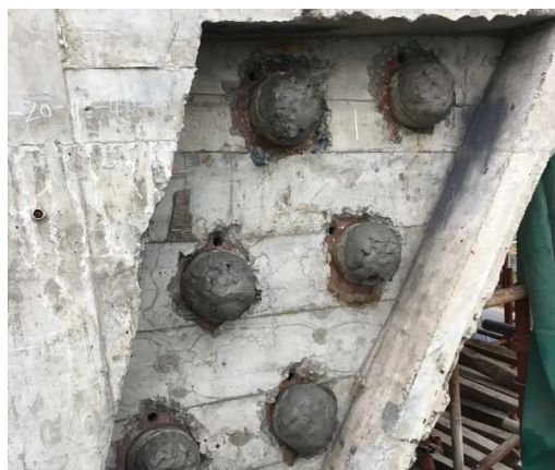
图4 封锚示意图
