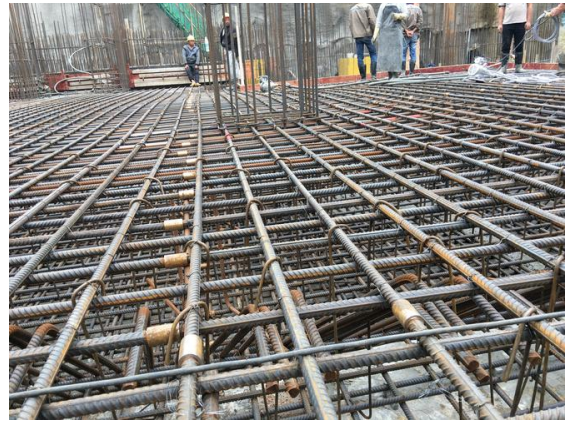
图1 钢筋骨架绑扎
