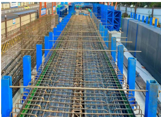
图2 T梁模板安装
