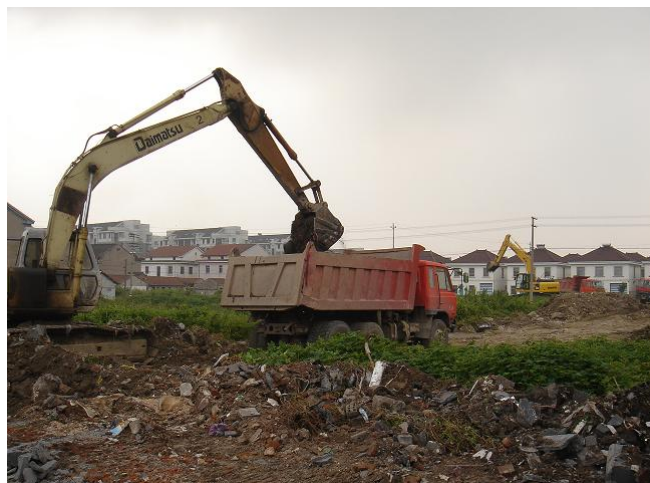
图：某建筑工程项目建筑废料集中清运现场
