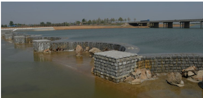
图2 墙式护岸
