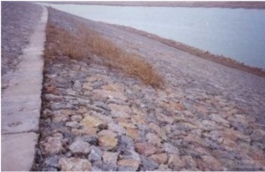
图1 坡式护岸
