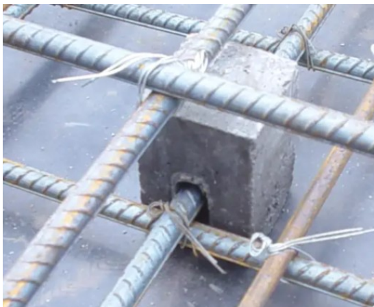
图1 钢筋垫块检查
