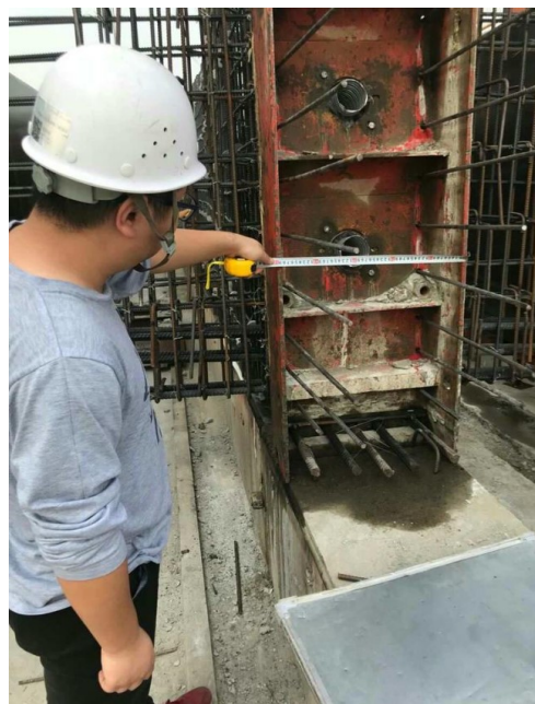
图一：梁钢筋模板的验收
