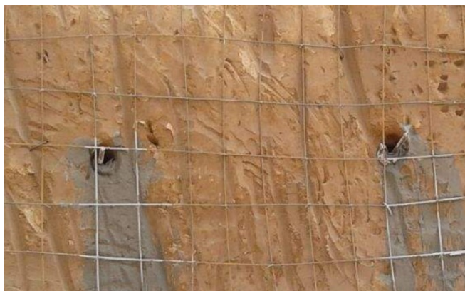
图 1：土钉支护技术应用示意图
