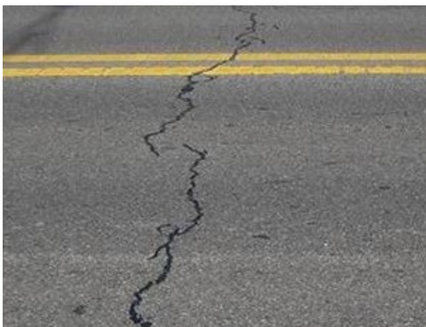
图2 路面裂缝
