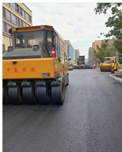
图1 SMA 沥青混合料碾压
