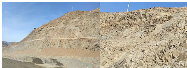
图1 矿区内治理区边坡岩体图
