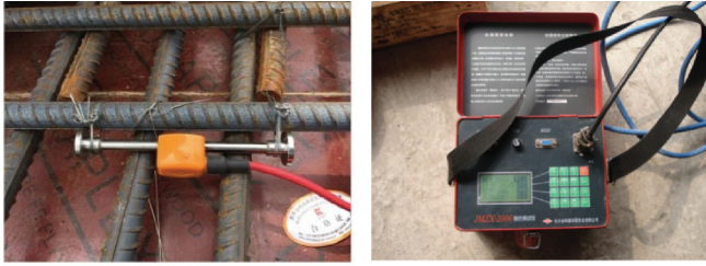
(a) 钢筋应力计安装 (b) 数据采集系统
