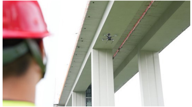
图1 无人机技术在桥梁施工现场应用
