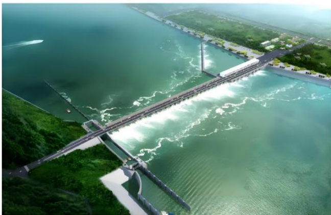
图1 某水利水电工程建设图
