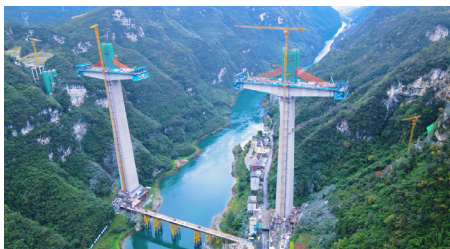
图 磨寨乌江特大桥
