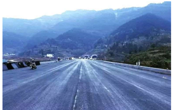
图1 高寒地区公路路基冻害防治的施工现场
