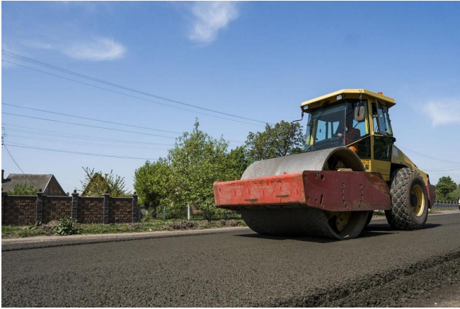
图2 振动压路机施工现场
