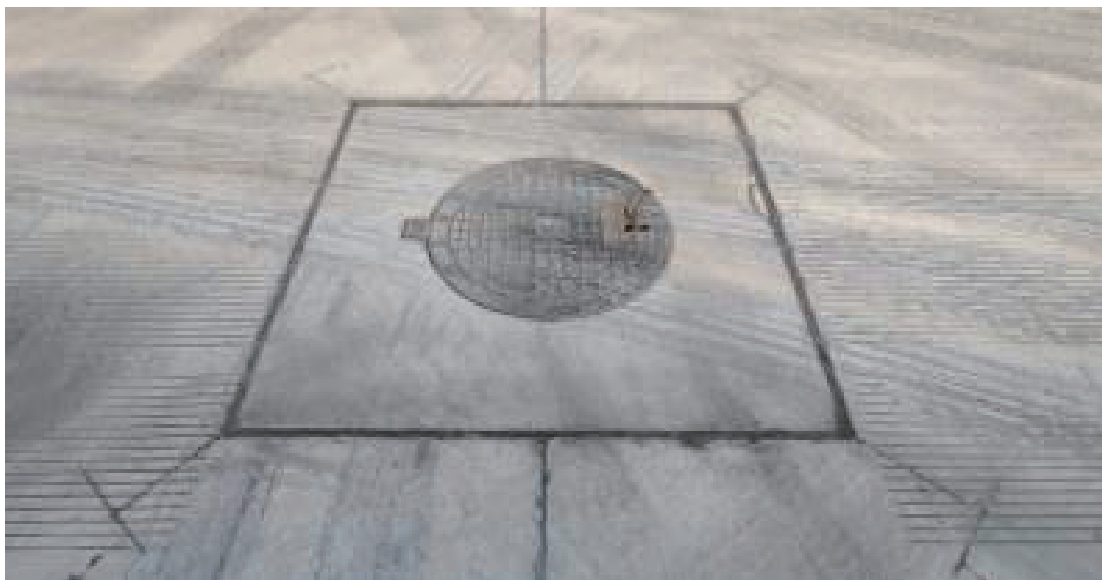
使用一年后回访无裂缝产生
