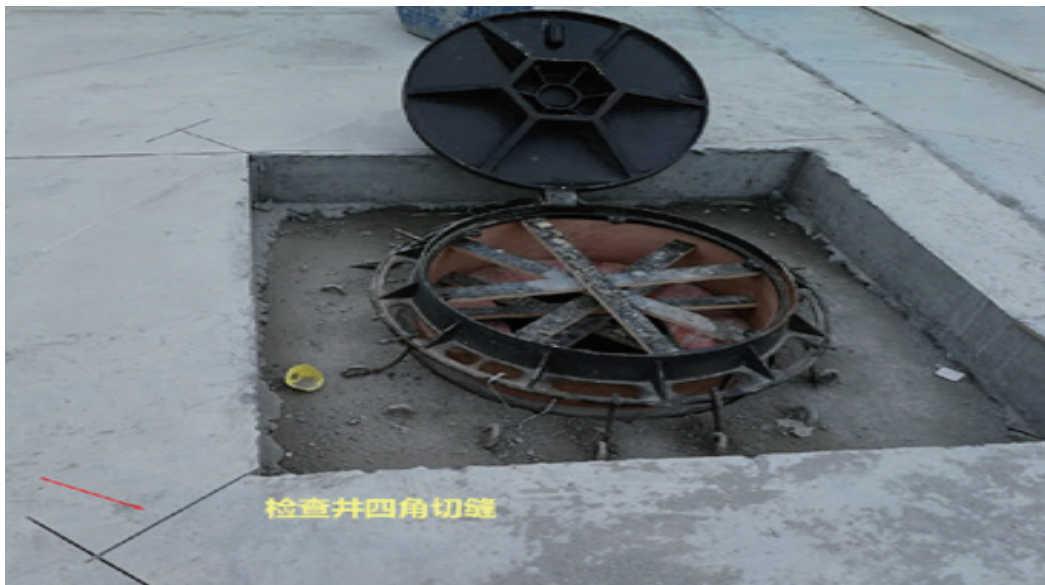
施工期防止裂缝的做法
