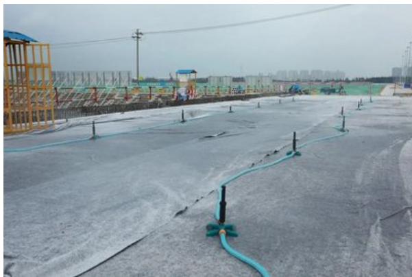
图二 混凝土的养护
