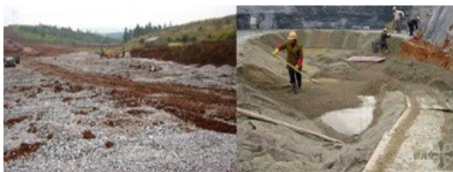
图1 换土垫层技术
