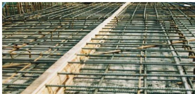
图3 施工缝分隔处理
