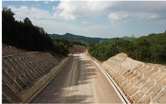
图1 高速公路路基施工
