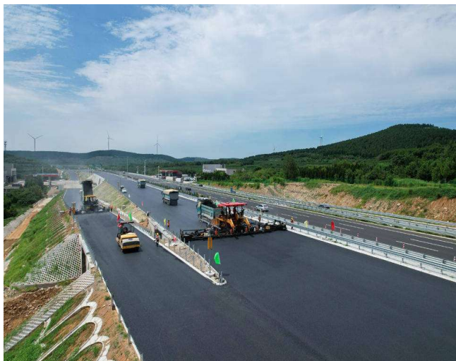
图2 高速公路路面施工
