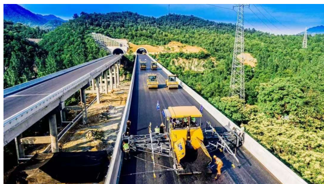
图2 智能路面养护现场作业航拍图
