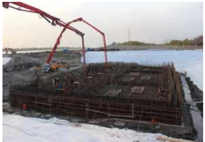
图1 某水利工程冬季混凝土施工现场
