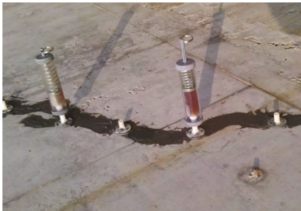
图一 混凝土裂缝注浆
