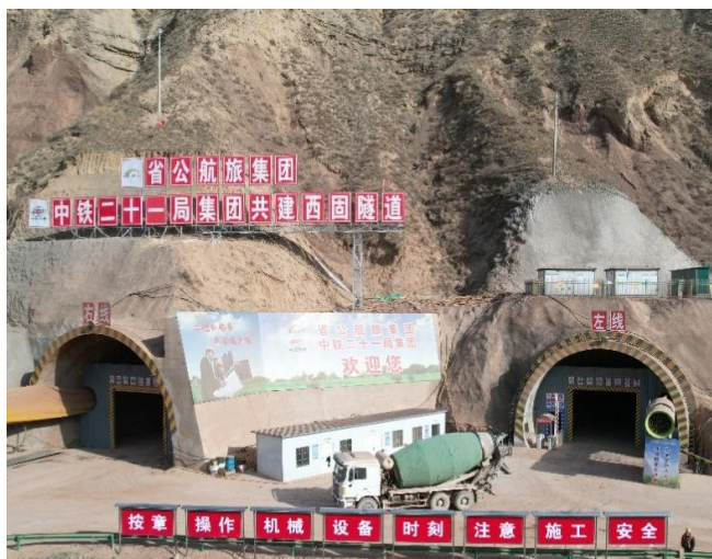
图2 兰永临高速公路西固隧道
