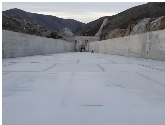
图二 防水施工
