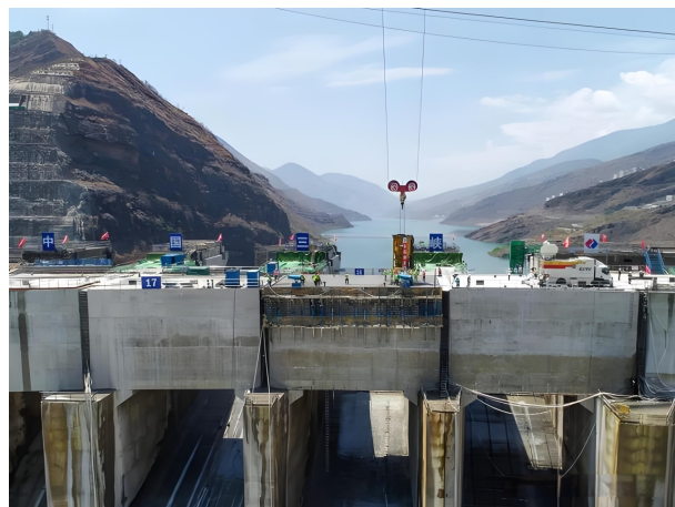
图一 高性能混凝土坝体
