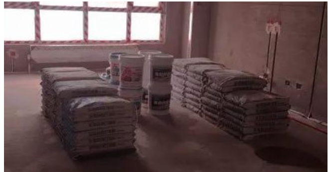
图2 装饰装修材料存放保护
