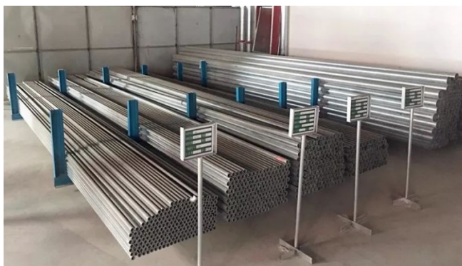
图1 钢管的现场标准化存放
