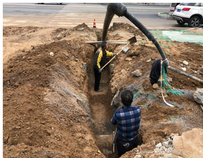
图1 燃气工程沟槽开挖
