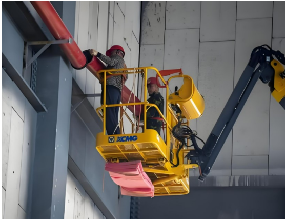
图2 燃气工程高空作业
