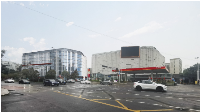
图片1 她妆四期厂房及配套设施建筑（左侧建筑）
