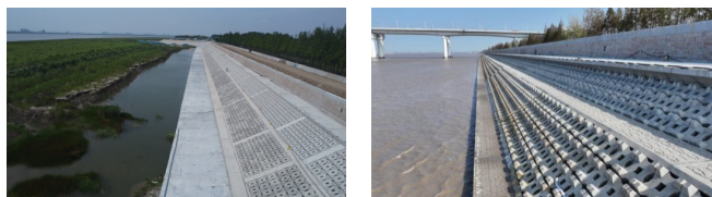
图 1、2 为堤脚防冲分部
