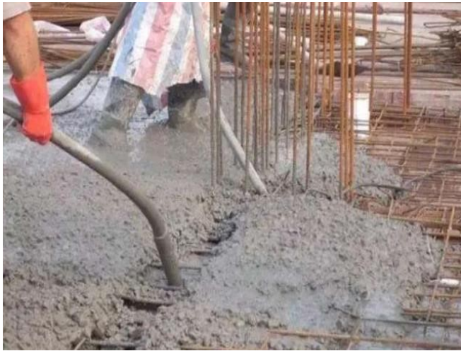
混凝土浇筑
