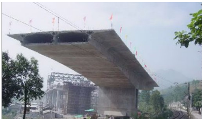
桥梁工程上部结构施工图
