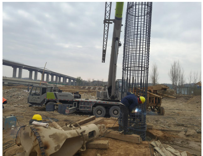
图1 桥梁钻孔灌注桩施工现场
