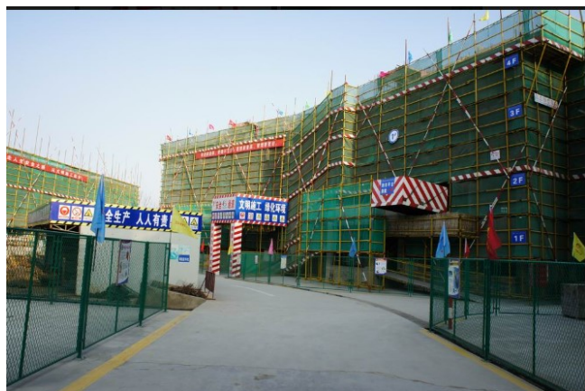
图2 施工现场设置安全标语、横幅
