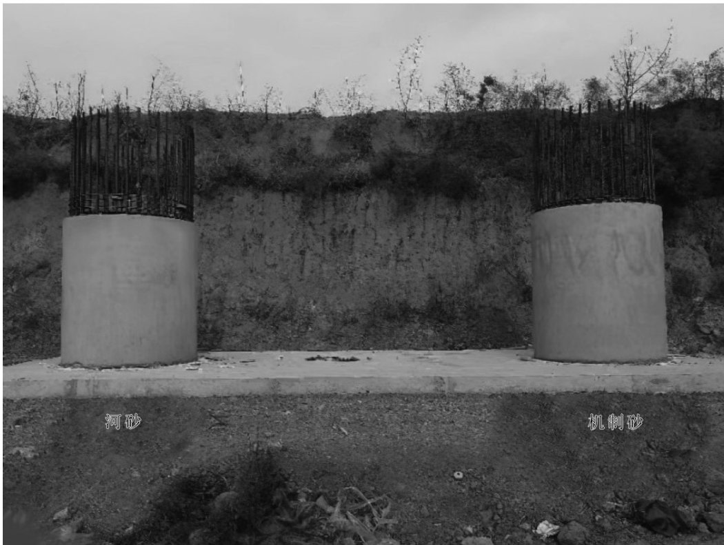
图2 现场试验墩柱
