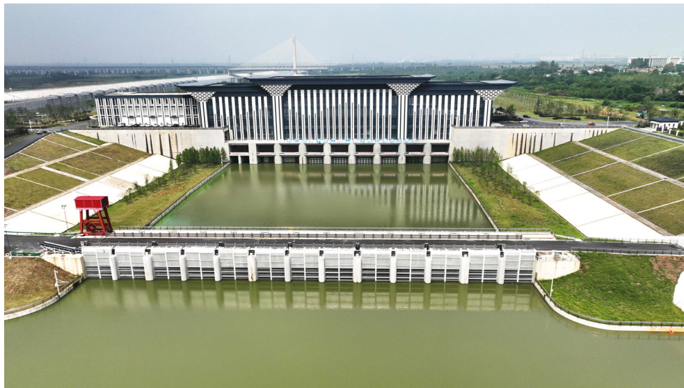
图1 引江济淮工程（安徽段）江淮沟通段施工 J005-1 标（水利部分）蜀山泵站工程
