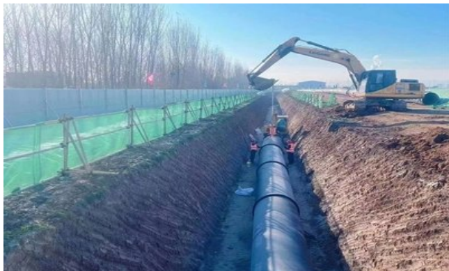
图1 管道安装施工图
