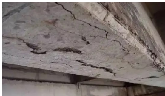
图2 钢筋锈蚀
