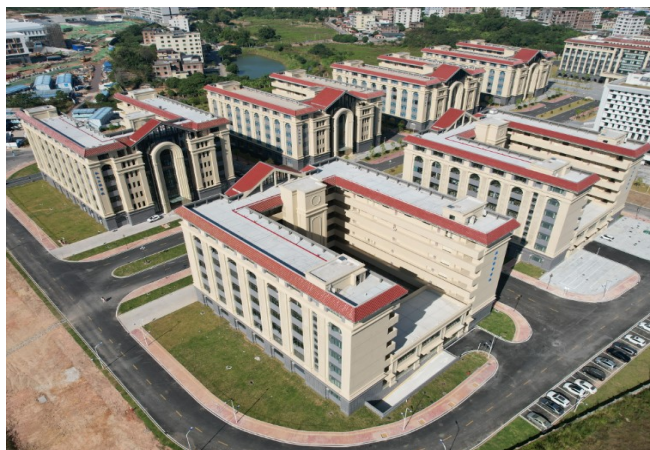
图2 工程竣工阶段
