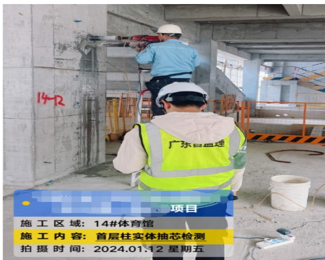
图1 主体混凝土结构工程实体检测
