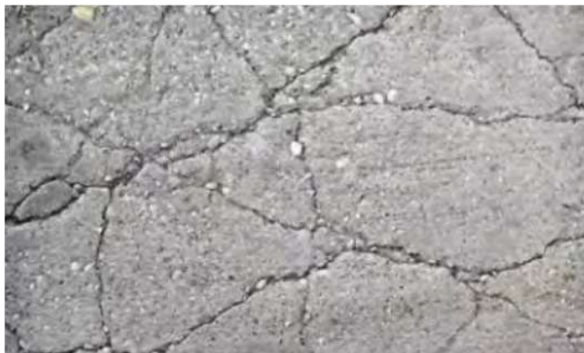
图2 干缩裂缝
