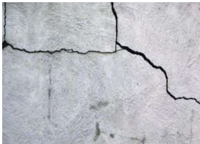
图1 温度裂缝
