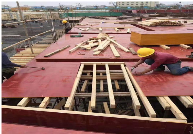
图1 建筑模板施工
