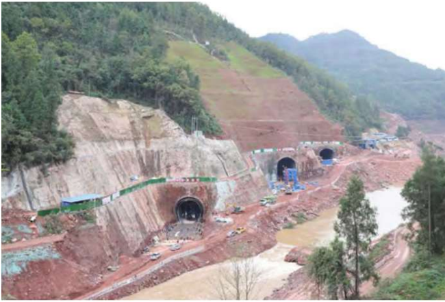
图1 水利工程隧洞导流施工
