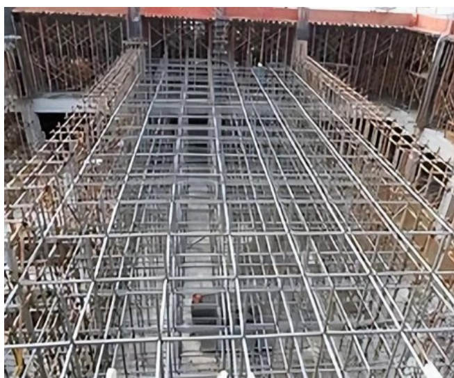
图1 高支模施工现场
