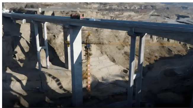
图 1 公路桥梁耐久性施工现场
