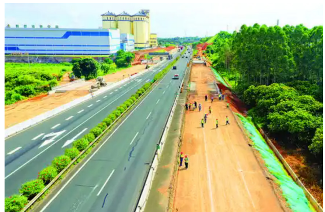
图1 路基加宽改扩建
