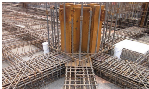
图1 全预应力混凝土施工
