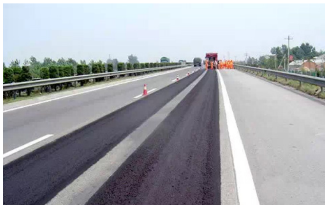
图1 路面抗渗漏施工
